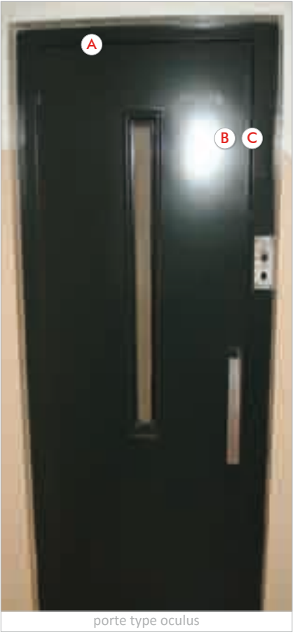
porte type oculus ex : serrure droite sur porte SORETEX type P
