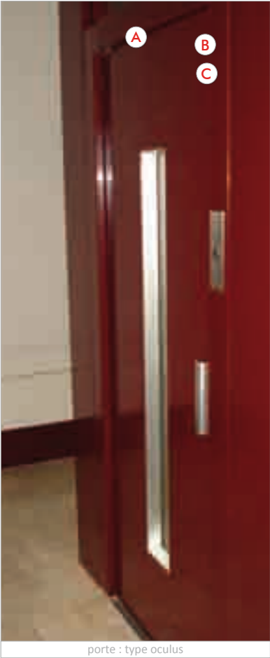
porte : type oculus ex : serrure droite sur porte OTIS PILO
